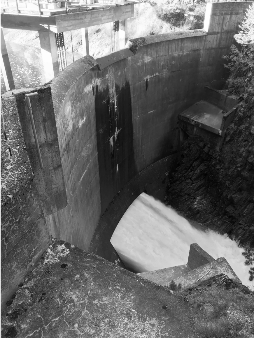
Abbildung 4: geöffneter Grundablass der Stauanlage «Zen Binnen» VS (© Bundesamt für Energie)
